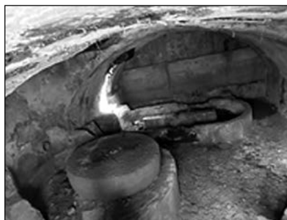
Estat actual de la mola i el cilindre (pila holandesa) del molí Major (2021)
