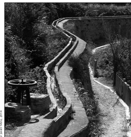
Tramo del itinerario del Parque Cultural del Agua
