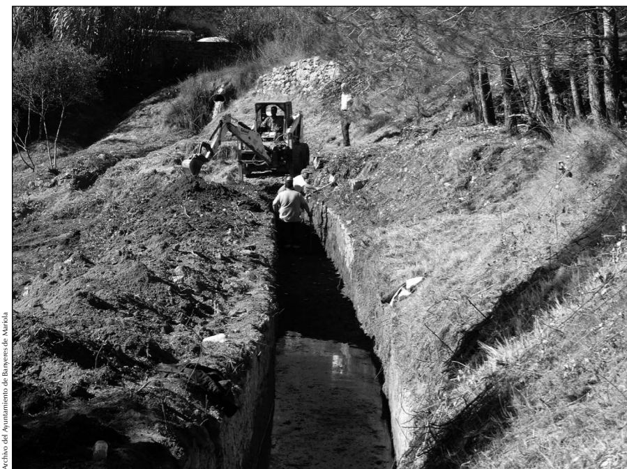
Brigada de obras del Ayuntamiento descubriendo la acequia
