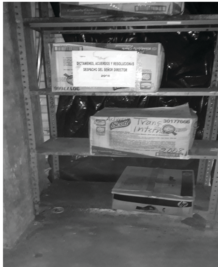
FIGURA N°. 39. Estantería que se recomendó que se quitara del depósito debido al alto grado de oxidación, luego de nueve años, aún está en el mismo lugar y con los mismos datos, el colmo es que ya ubicaron nuevamente documentación en las bandejas.
