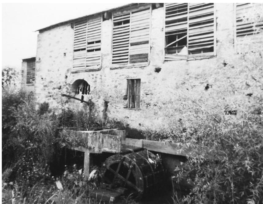
**Fotografia 11.** Levada e uma das rodas hidráulicas. MFR, 1988
