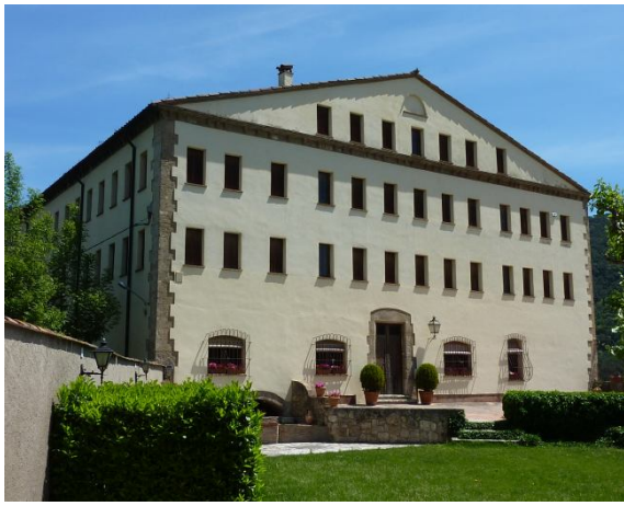
Fig. 14. Fábrica Munné. 118 ventanas distribuidas en tres niveles
