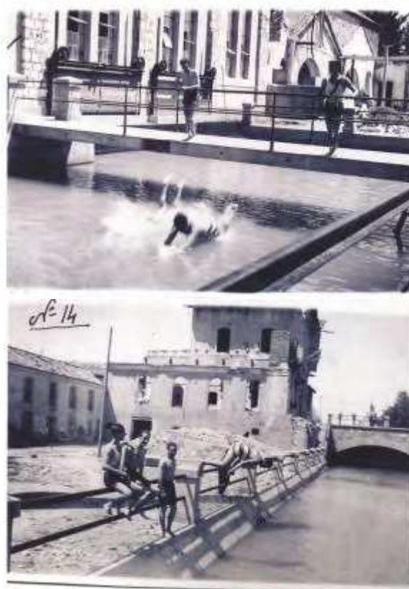
Figuras 25 y 26.- Obras de acondicionamiento de la antigua fábrica. Fotografía Luis Escobar. Año 1931.
