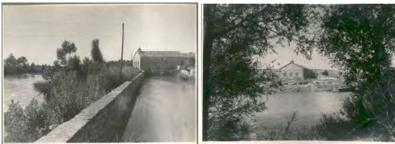
Figuras 23 y 24.- Vista de las compuertas de la cámara de carga de la Central de San Alejandro y vista exterior de la Central Hidroeléctrica de San Alejandro desde la margen derecha del río Júcar. H. 1944.
