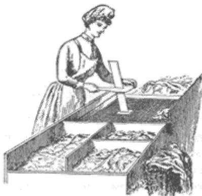
Figura 2. Corte de papel de trapo para fabricación de papeles con celulosa pura.
