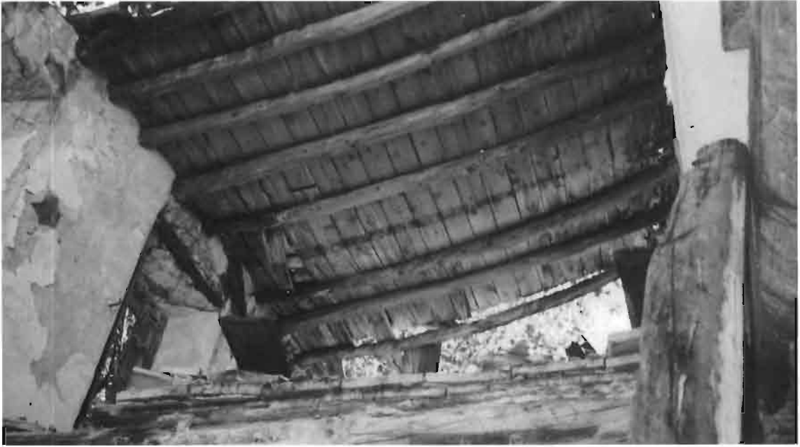
Estado actual cubierta Molí Pont
