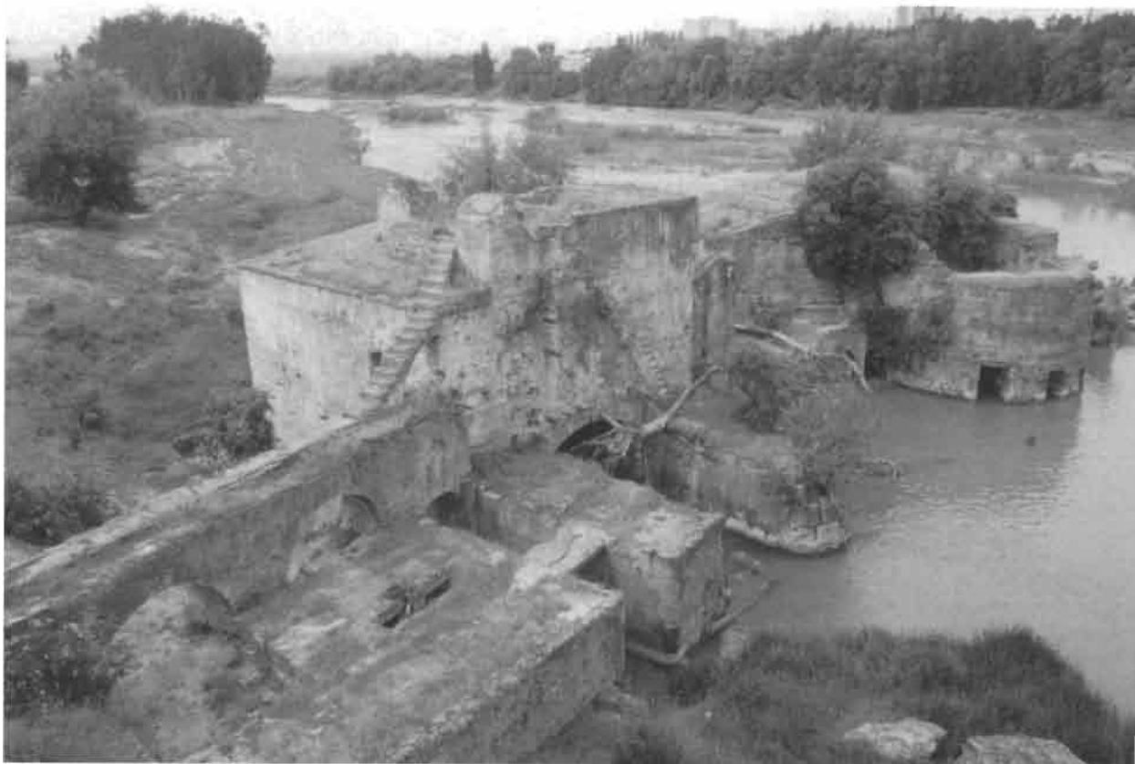
Vista de los molinos de San Rafael y San Lorenzo desde el Puente de San Rafael. El más adentrado en la corriente es el de San Rafael; edificado con anterioridad al siglo XIX, en 1849 el pequeño molino harinero hasta entonces existente (que debía coincidir con la forma de ábside que se aprecia) fue transformado en una amplia instalación de siete piedras (la nave con cubierta a cuatro aguas). El situado junto a la orilla es el de San Lorenzo, que fue edificado como molino de papel y hoy está arruinado tras sufrir importantes transformaciones arquitectónicas (instalación de turbina generadora de energía eléctrica), aunque aún subsisten algunos elementos relacionados con la fábrica de papel decimonónica.
