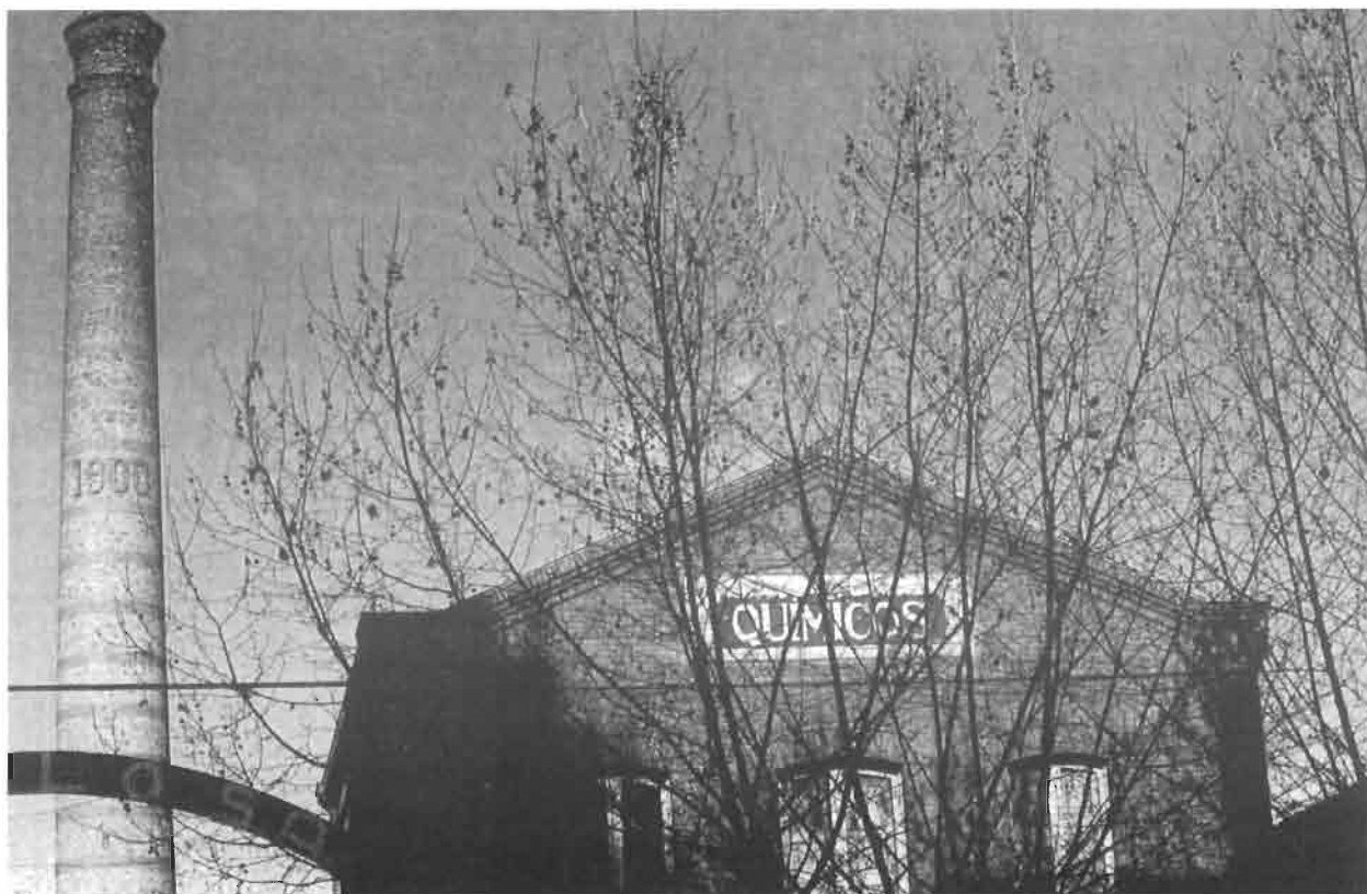
2. La fecha de la chimenea ha quedado como único dato visible de la fecha de la construcción de la papelera.
