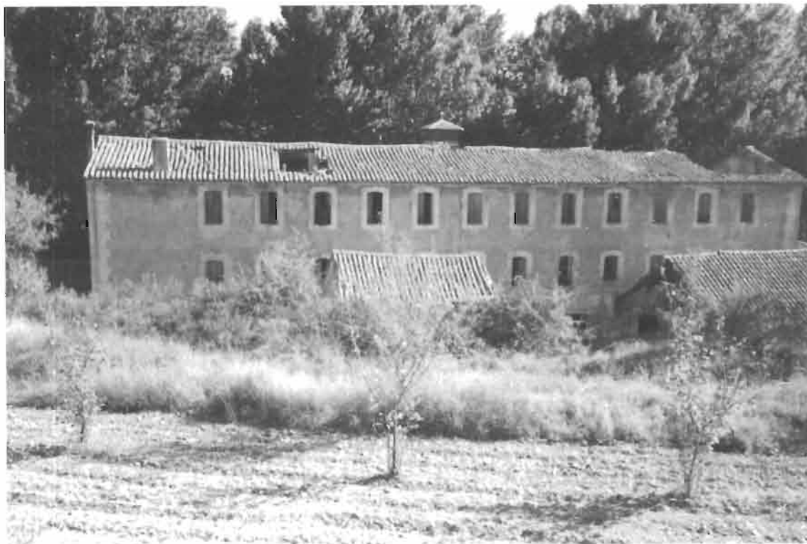
Vista Meridional del Molí Pont. Futura sede del Museu Paperer de Banyeres de Mariola.
